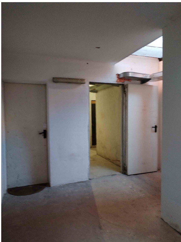
Foto 9. Accesso cantine al piano cantinato
