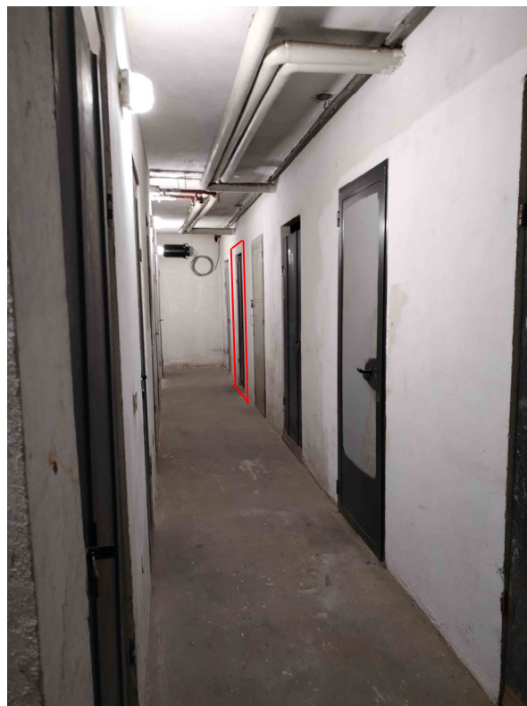
Foto 10. Corridoio cantine e porta d'accesso cantina
