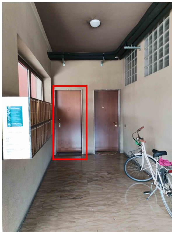
Foto 6. Porta d'accesso all'appartamento
